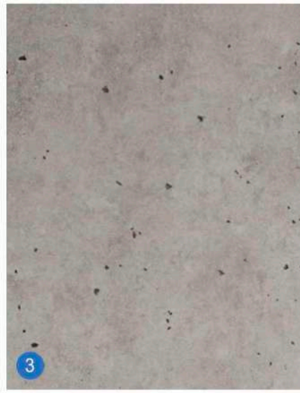
3 šviesiai pilkas, surenkamo gelžbetonio fasadas
