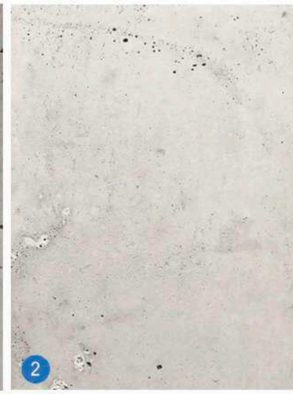
2 šviesus, baltas, surenkamo gelžbetonio fasadas
