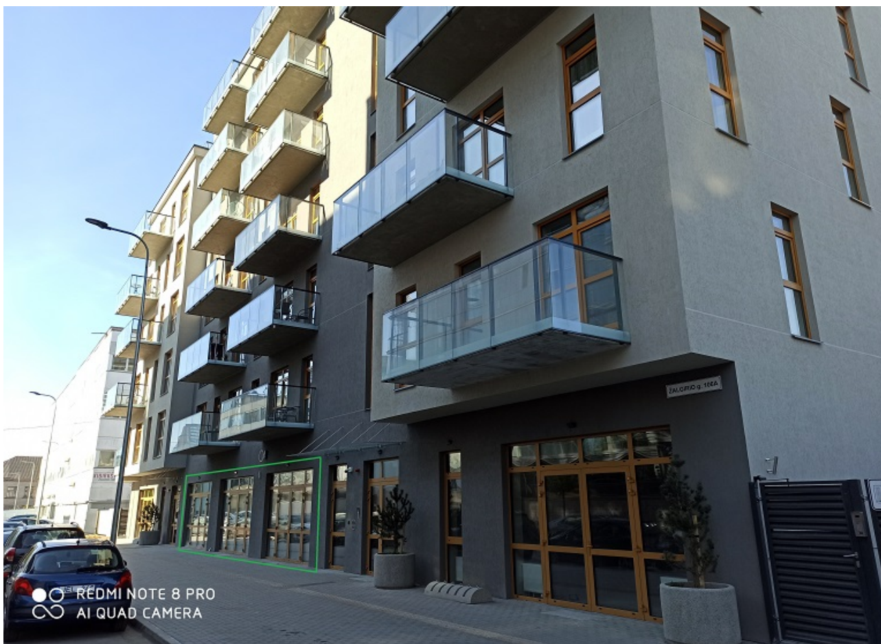
3 pav. Pastato fasadas.
