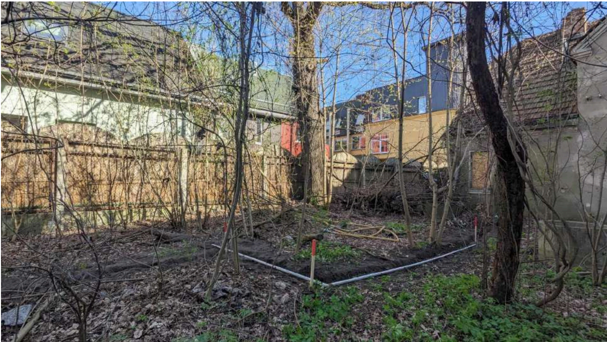
Pav. 4.3.4. Šaknų revizinė tranšėja oro kastuvo pagalba buvo iškasta palei projektuojamų statinių perimetrą.
