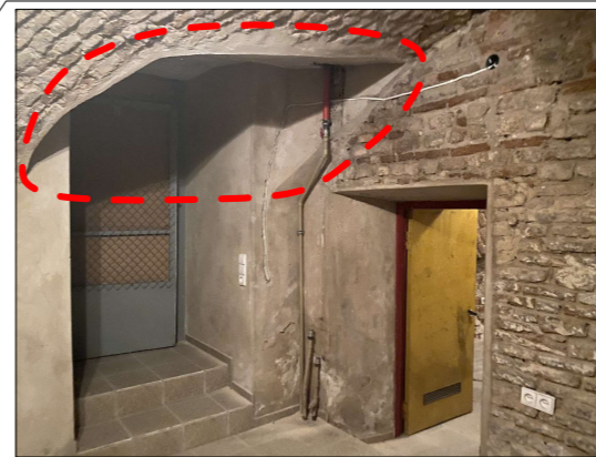
Užbetonuotas mūrinės skliautinės perdangos fragmentas
