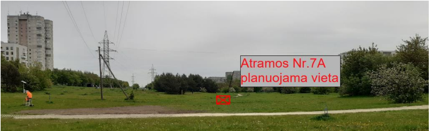
2 pav. 110 kV oro linija Šeškinė – Šiaurinė I, II 7A atramos statybos vieta.
