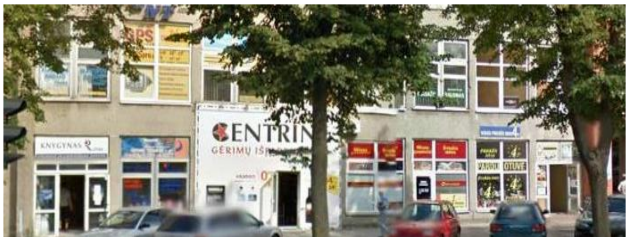
IVR įrenginiai ant pastato fasadų Kalvarijų gatvėje.
