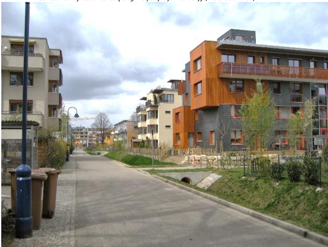
Pav. Nr. 2.4.-36. Gatvės infrastruktūros įrengimo pavyzdys Breisgau Freiburge, Vokietijoje, 2016 m.
