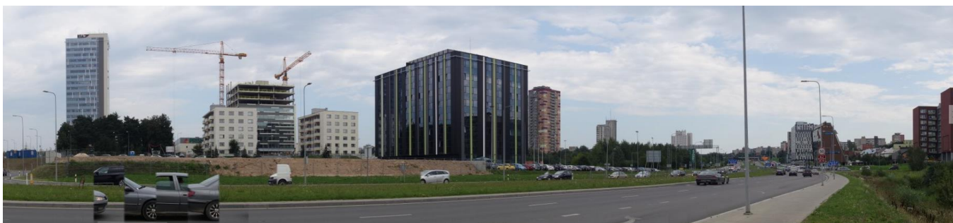
Pav. Nr. 2.2.1-17. Aukštybinis pastatas Viršuliškių skg. 34 (verslo centras)
