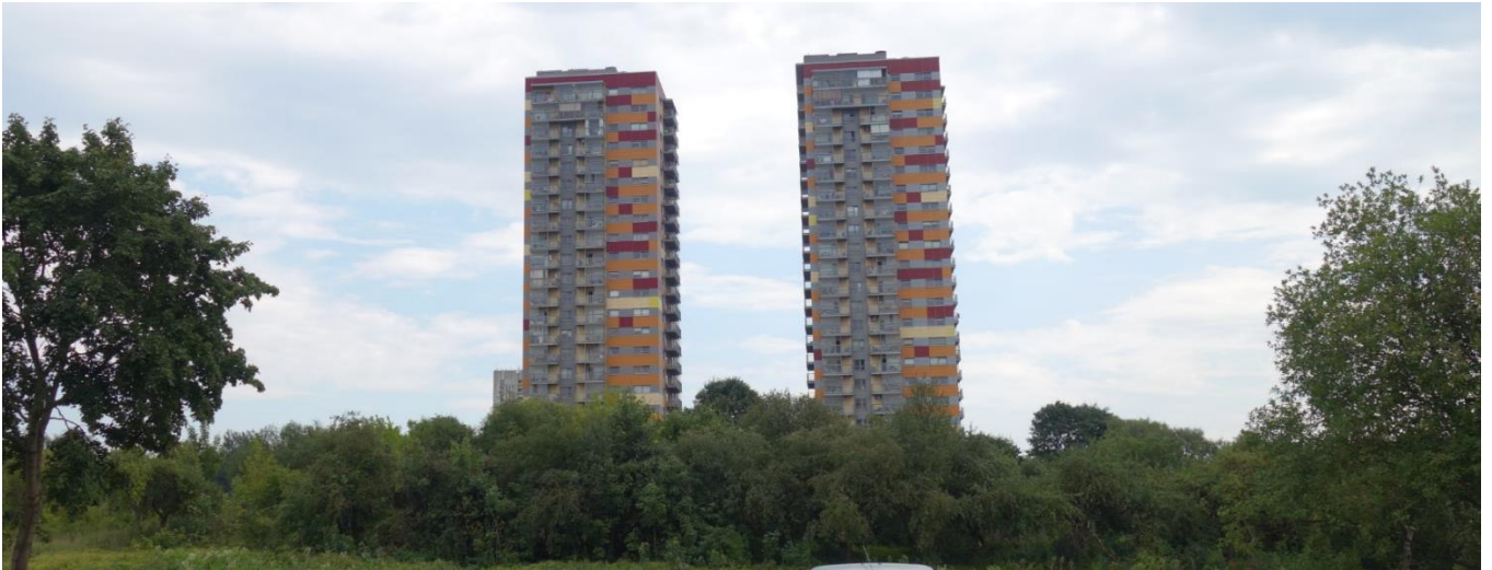
Pav. Nr. 2.2.1-16. Aukštybiniai pastatai Viršilų g. 11 (gyvenamieji namai)
