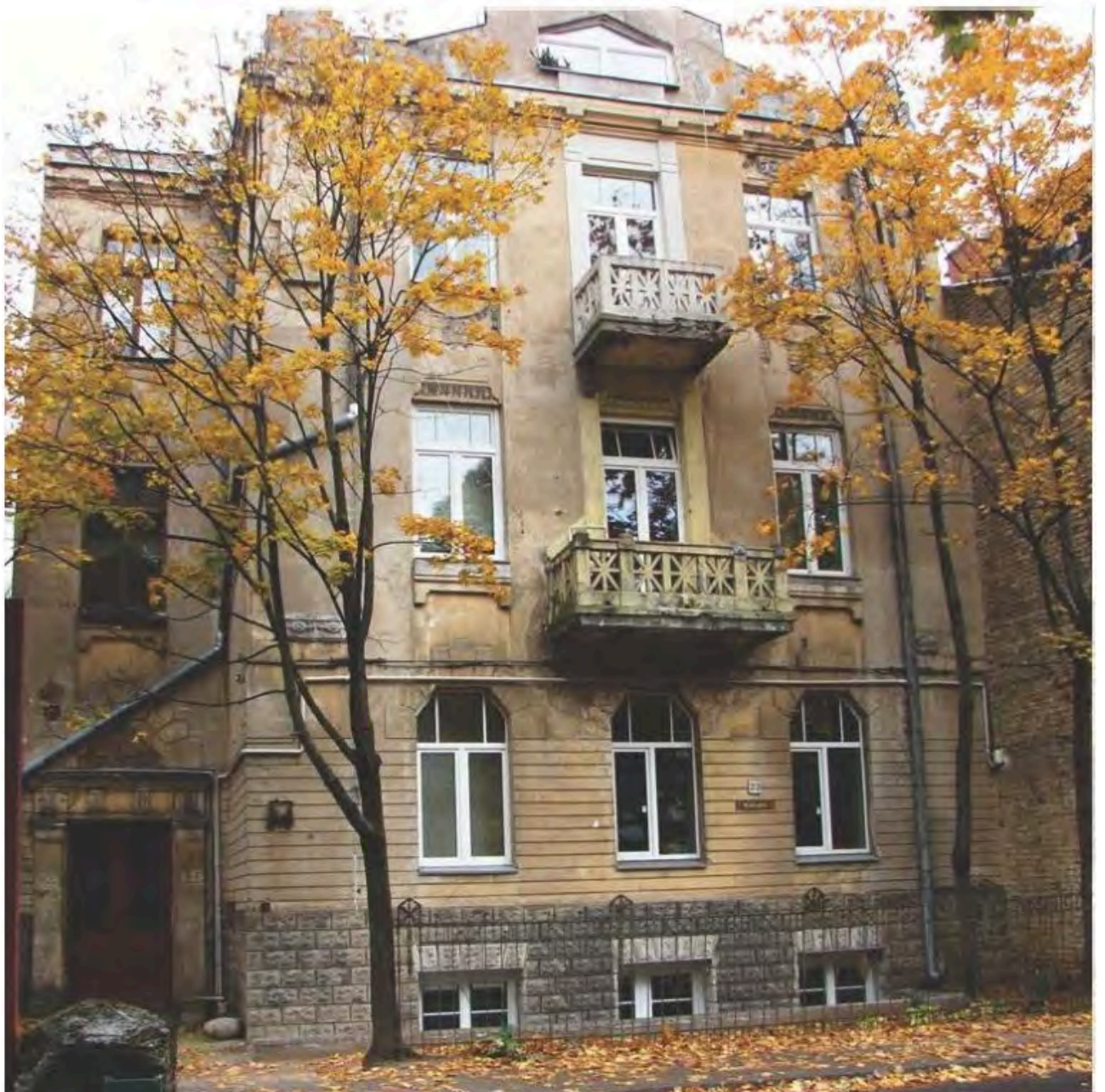
3 pav. Pastato fasadas.
