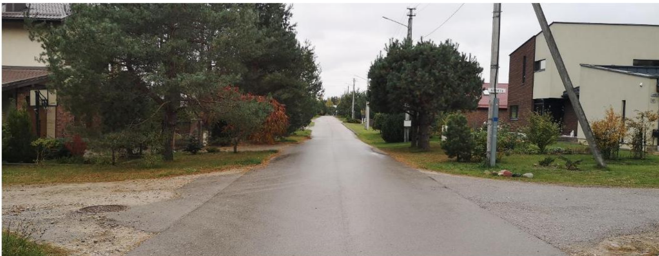
Foto fiksacija Nr. 1. Jundos gatvės sankryža su Aušrinės gatve rytų kryptimi
