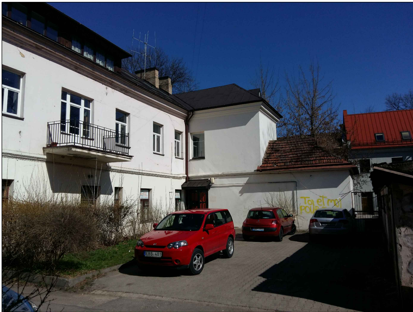
FOTO NR. 1 PIETVAKARINIS PASTATO FASADAS
