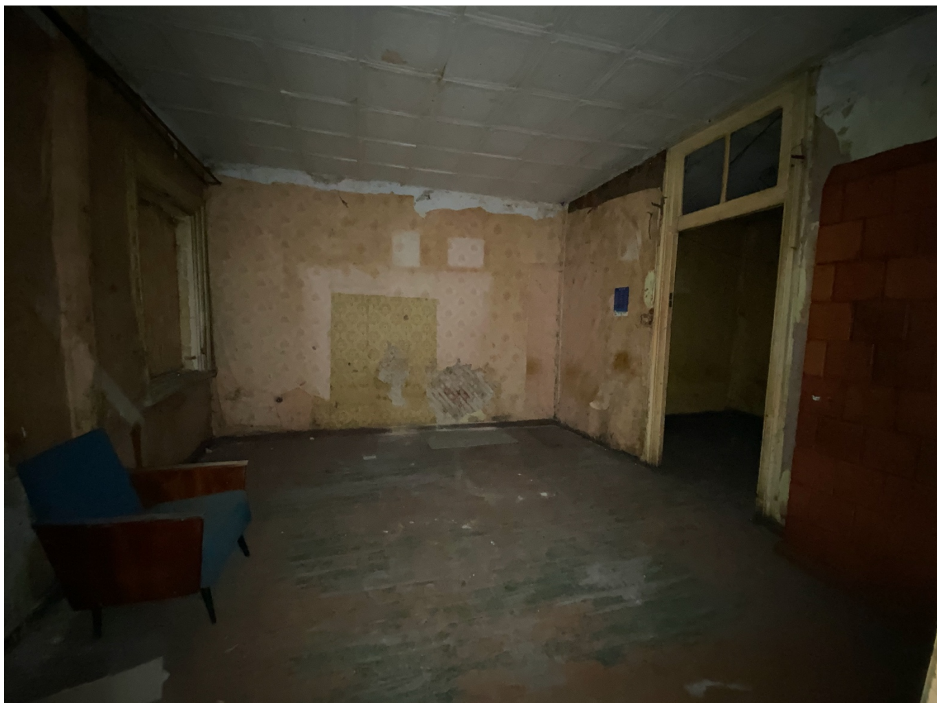
2 pav. Projektuojamų patalpų būklė
