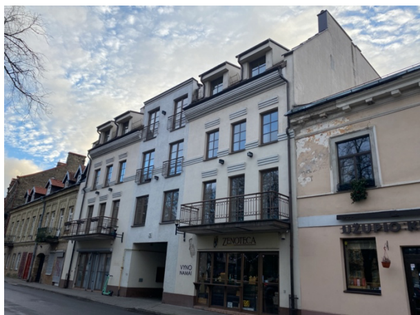
Pagrindinis gatvės fasadas
