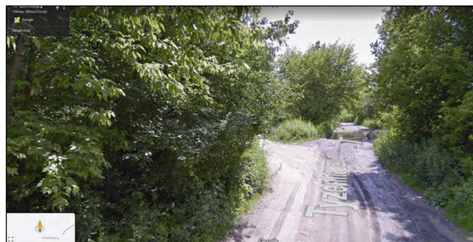
2. Tyzenhauzų gatvės būklė ties sankryža su Jotvingių gatve
