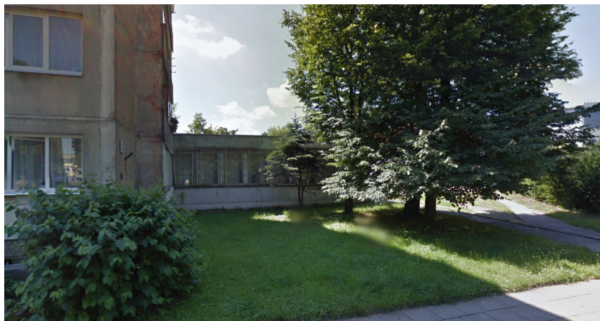
2 pav. Remontuojamas pastatas
