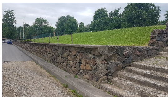
3.13 pav. Akmeninė atraminė sienutė
