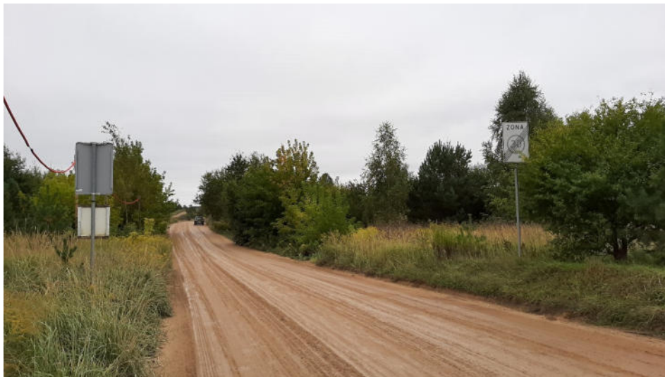
5 pav. Esama Karaliaučiaus g. dangos konstrukcija ties projektuojamo ruožo pabaiga
