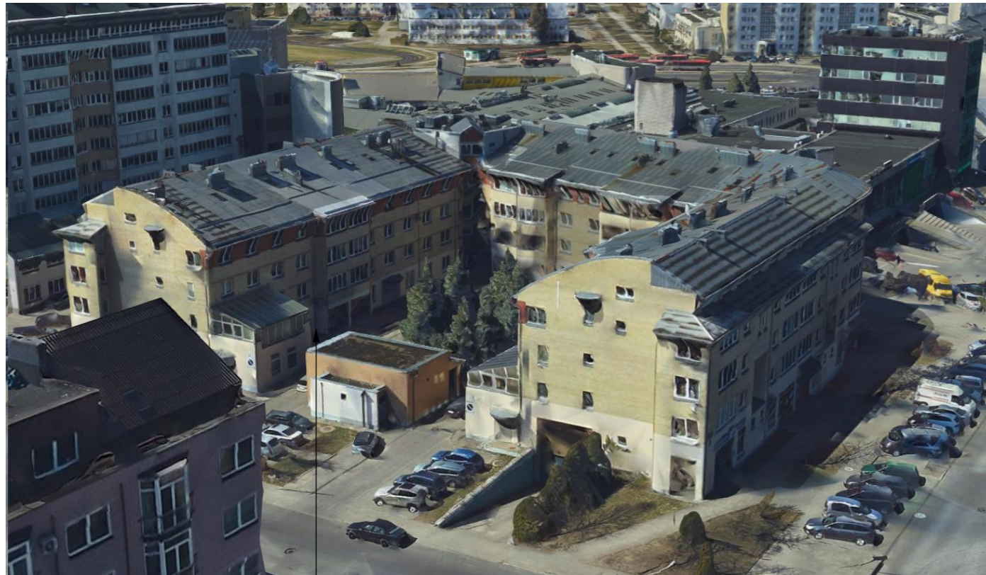
Laisvės pr. 123, remontuojamas pastatas.
