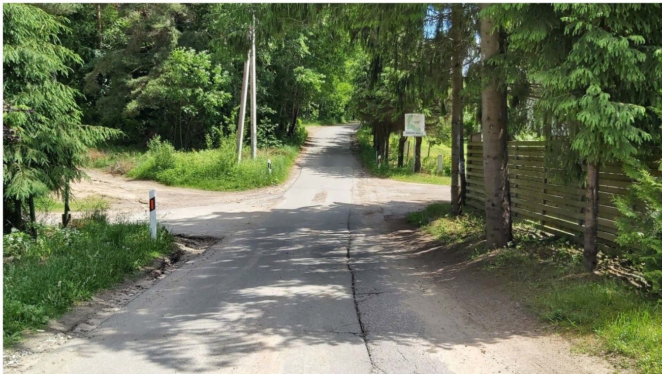
Pav.4 Esamos Anapilių gatvės danga
