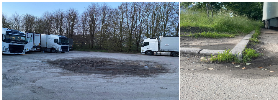
2 pav. Esama aikštelės būklė
