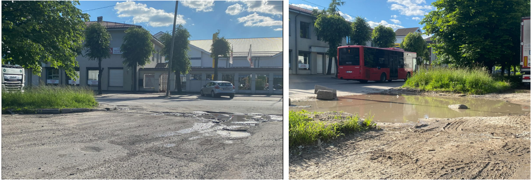
3 pav. Įvažiavimų / išvažiavimų dangos būklė
