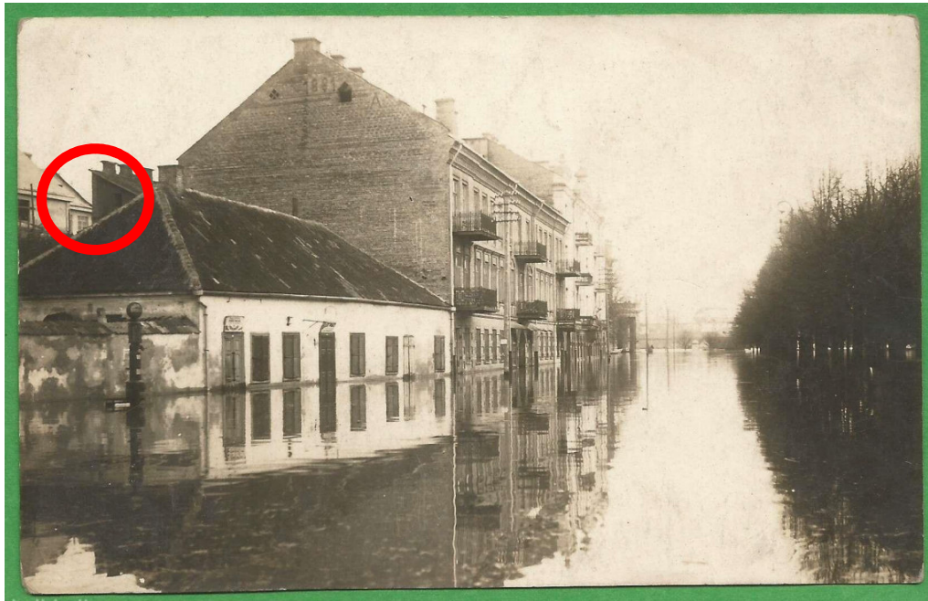
Pastogės aukšte neįrengtoje pataloje nr. 16A yra matomos trys užmūrytos angos (langai) matomi fotofiksacijoje. Šiaurės rytų fasade. Buvę langai ugniasienėje.
