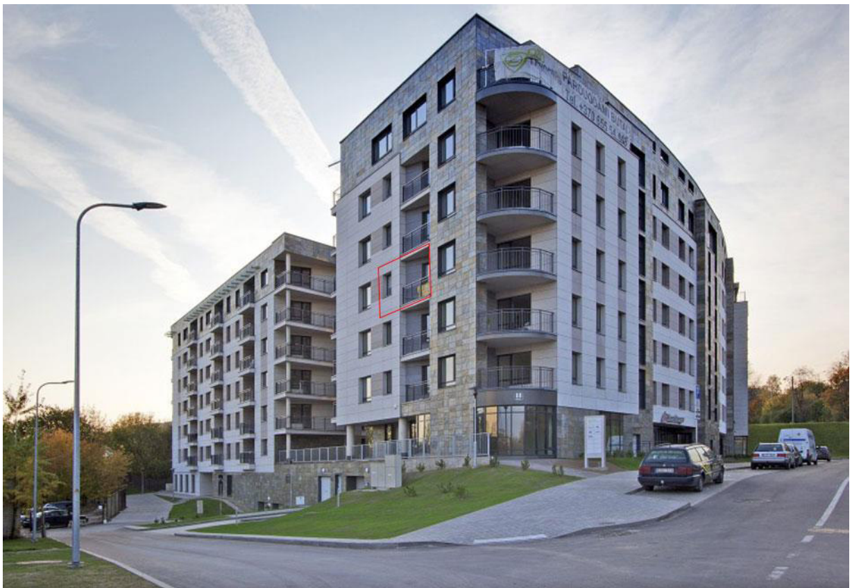
Projektuojamų patalpų Nr. 111 vieta esamo pastato pietiniame fasade
