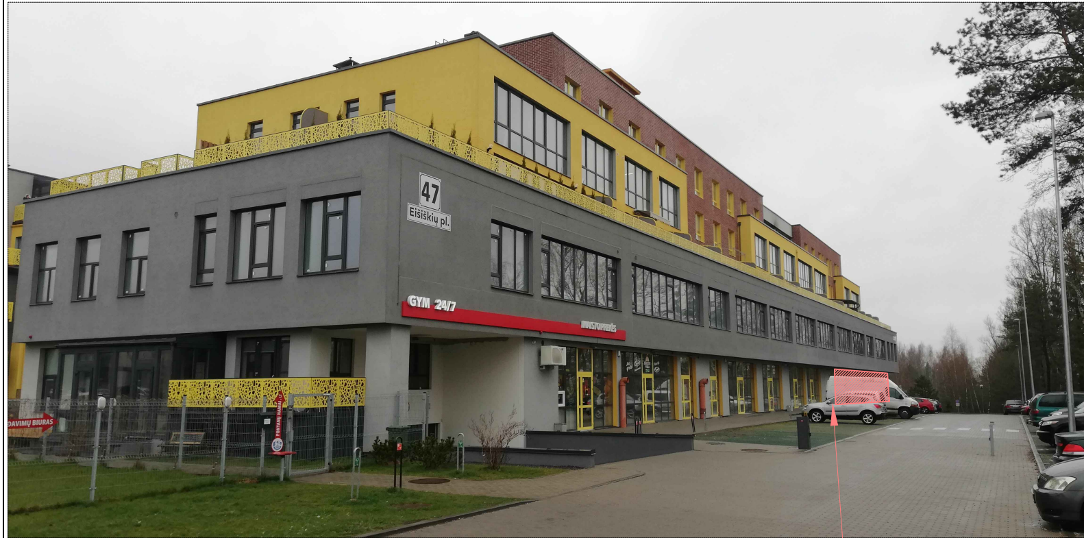
Objekto Rytinis fasadas
