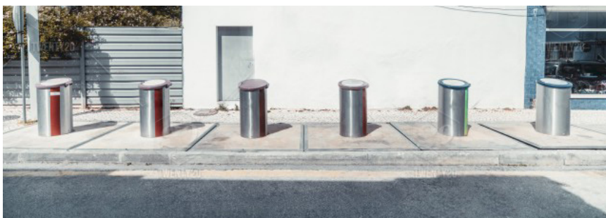
Požeminių konteinerių paviršiuje pavyzdys
