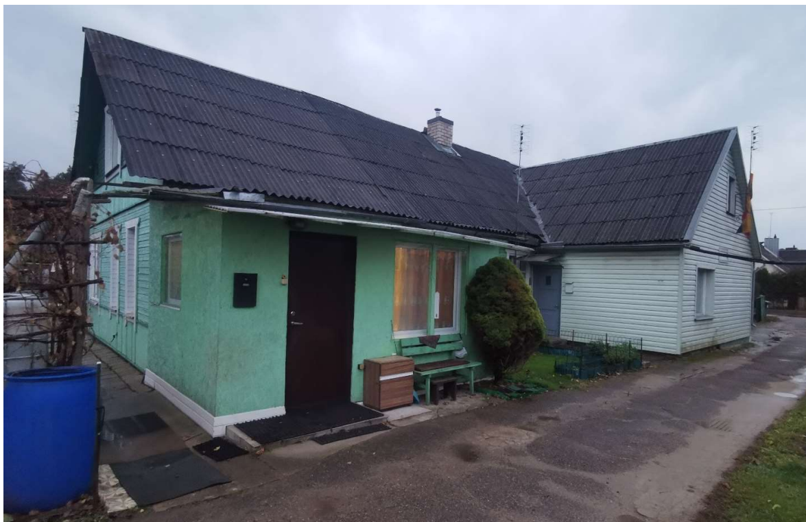
4 pav. Pastato šiaurės-rytų ir pietrytinio fasadų vaizdas iš rytų.
