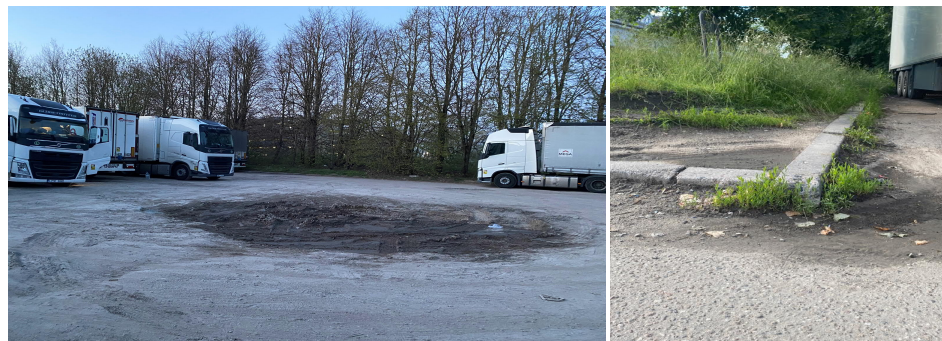
2 pav. Esama aikštelės būklė
