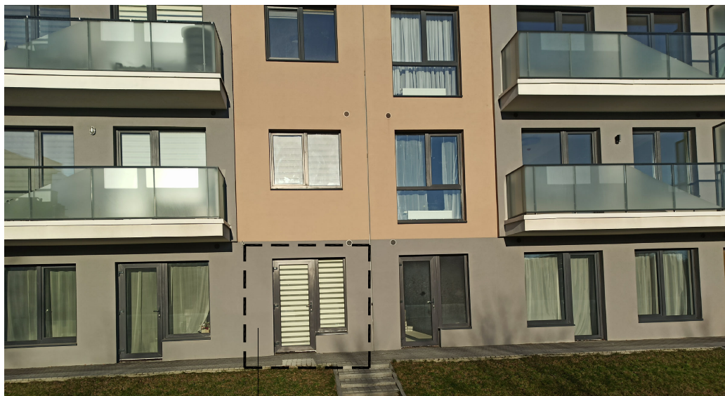
REMONTUOJAMA PASTATO DALIS
