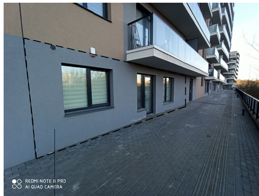
REMONTUOJAMA PASTATO DALIS
