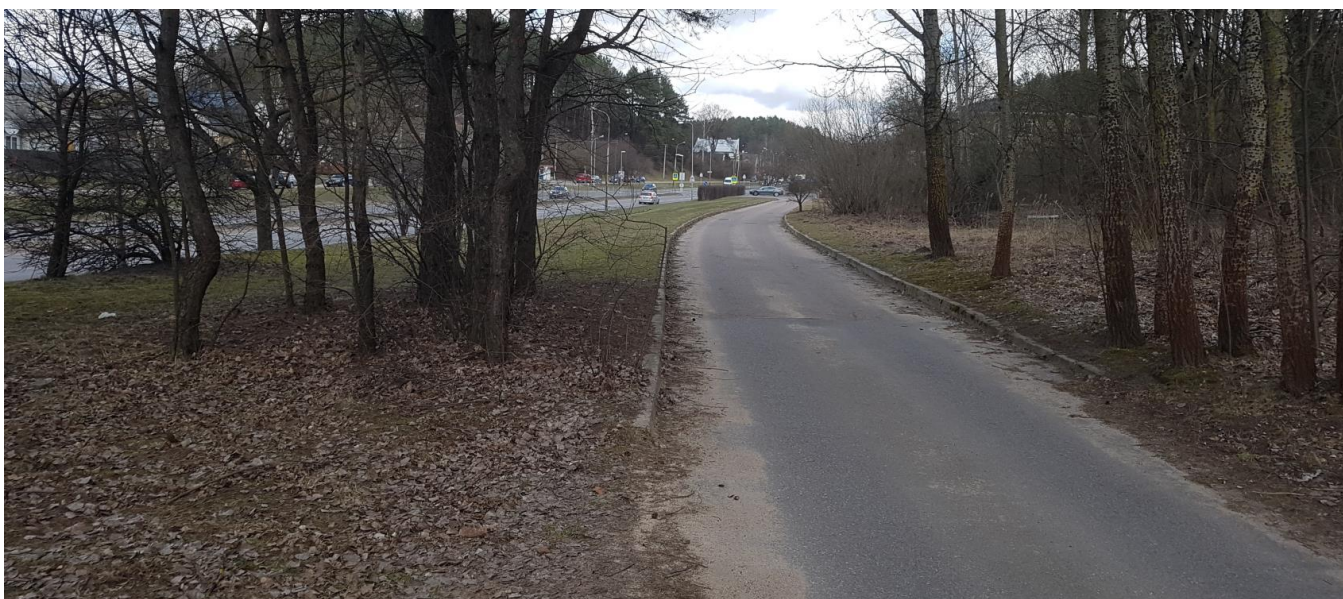
3 pav. Esama situacija Srovės gatvėje
