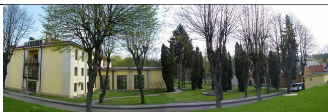
5. Vaizdas iš vakarų, nuo vandens rezervuarų. Kairėje – siurblinė, dešinėje – sarginės pastatas.
