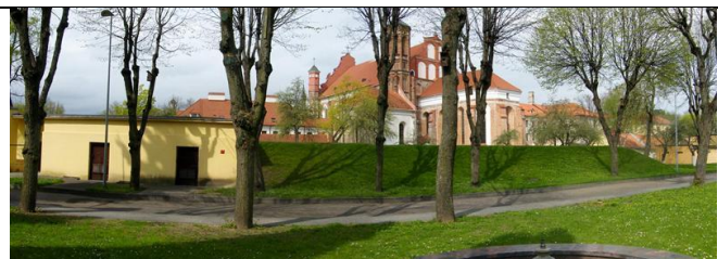
6. Vilniaus vandenvietės pastatų kompleksas
