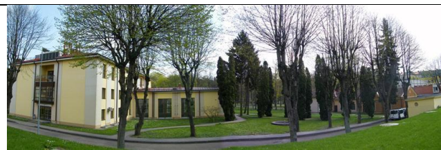
5. Teritorijos rytinė dalis. Vaizdas iš vakarų, nuo vandens rezervuarų. Kairėje – siurblinė, dešinėje – sarginės pastatas.
