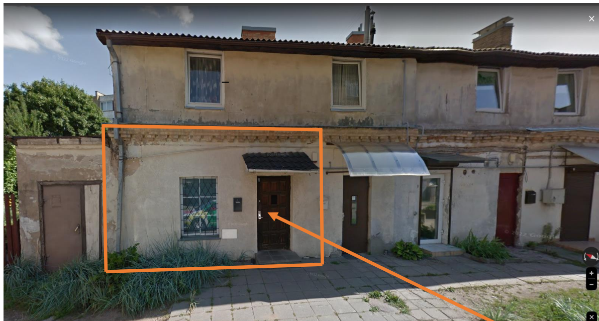
Remontuojamos patalpos (keičiama paskirtis į gyvenamąją) Naugarduko g 27-7
