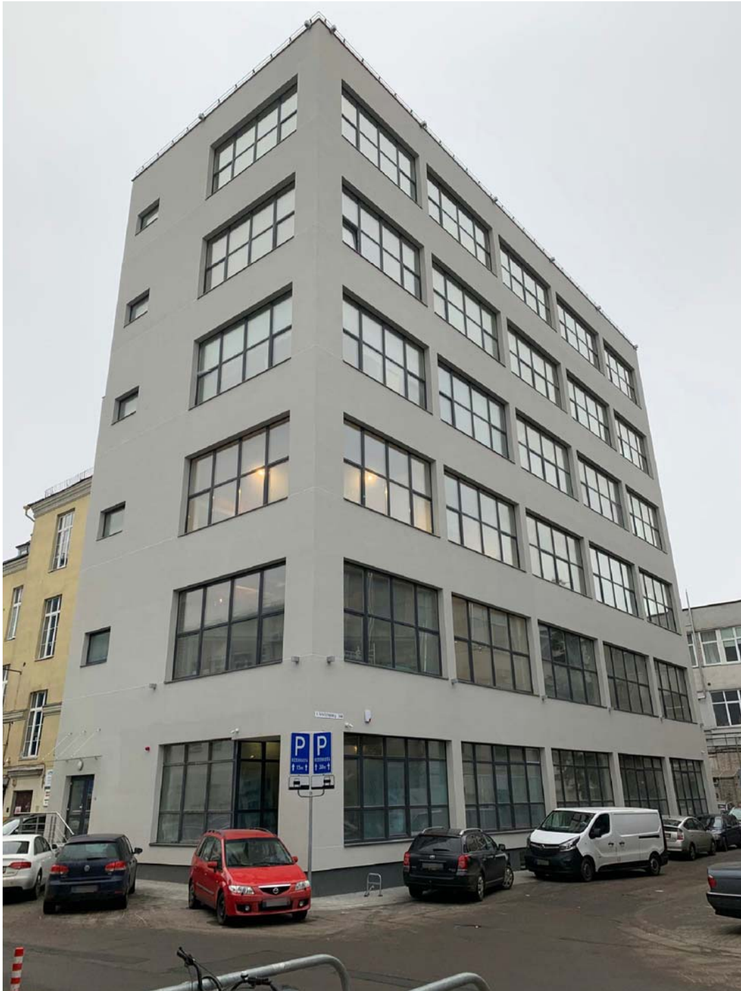
Remontuojamos pirmo aukšto patalpos
