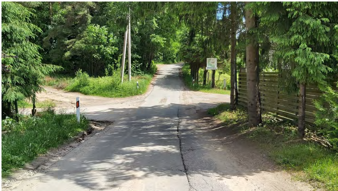
Pav.4 Esamos Anapilių gatvės danga
