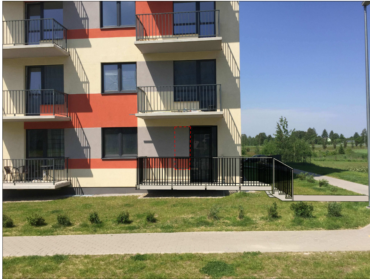
Demontuojamas 1a. langas, įrengiamos virtininės durys. Užmūrijama lango anga, atstatomas šiltinimo sluoksnis ir sienų apdaila pagal esamą spalvinį sprendinį.
