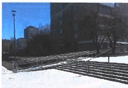
5.11. pav. Esami sutvarkyti betoniniai laiptai su pandusu šalia mokyklos
