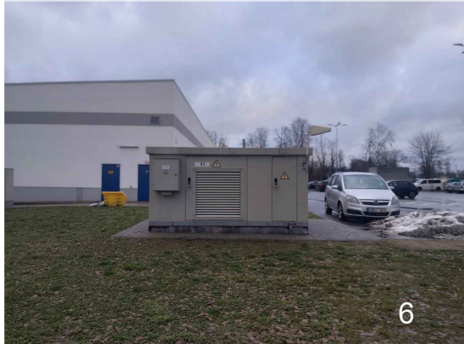
EL. TRANSFORMATORINĖ, ĮSITERPUSI TARP ESAMO IR PROJEKTUOJAMO PASTATŲ
