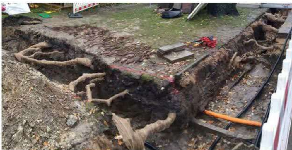
3 pav. Tranšėjos ir gatvės konstrukcijos lovio kasimo išsaugant medžių šaknis pavyzdys
