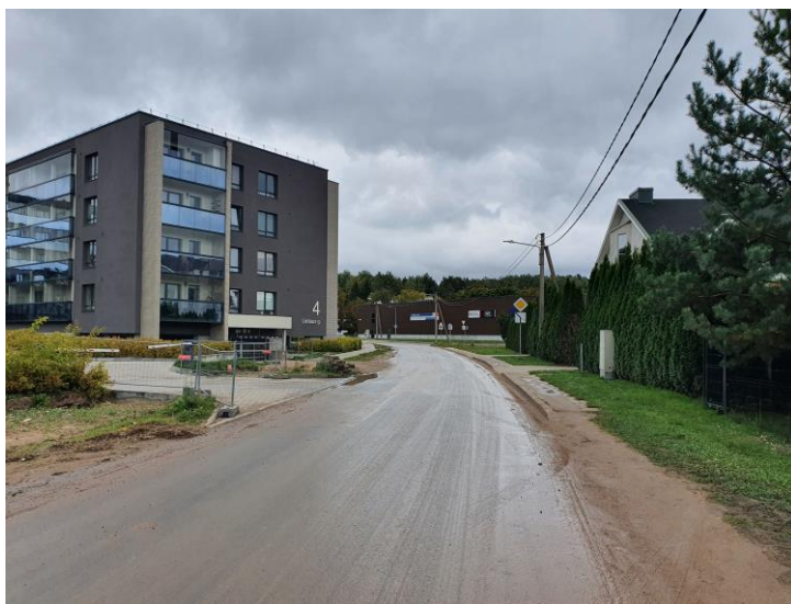
6 pav. Esama situacija Lietaus g. atkarpoje (gatvės pradžioje esami daugiaaukščiai gyvenamieji pastatai)
