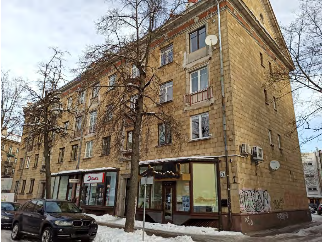
3 pav. Pastato fasadas.
