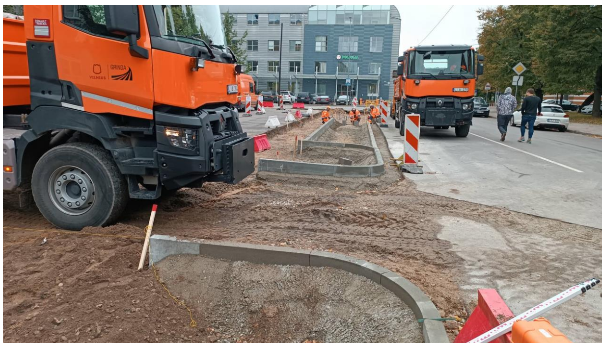
1 pav. T. Ševčenkos gatvės remonto darbai
