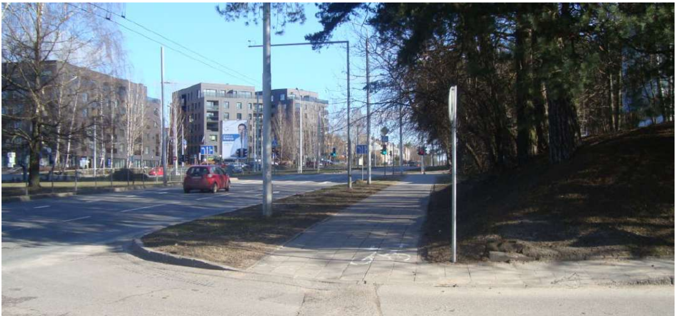
3.5 pav. Nemenčinės pl. esamos būklės fotografacija. Skersinio profilio elementų pasikeitimas.
