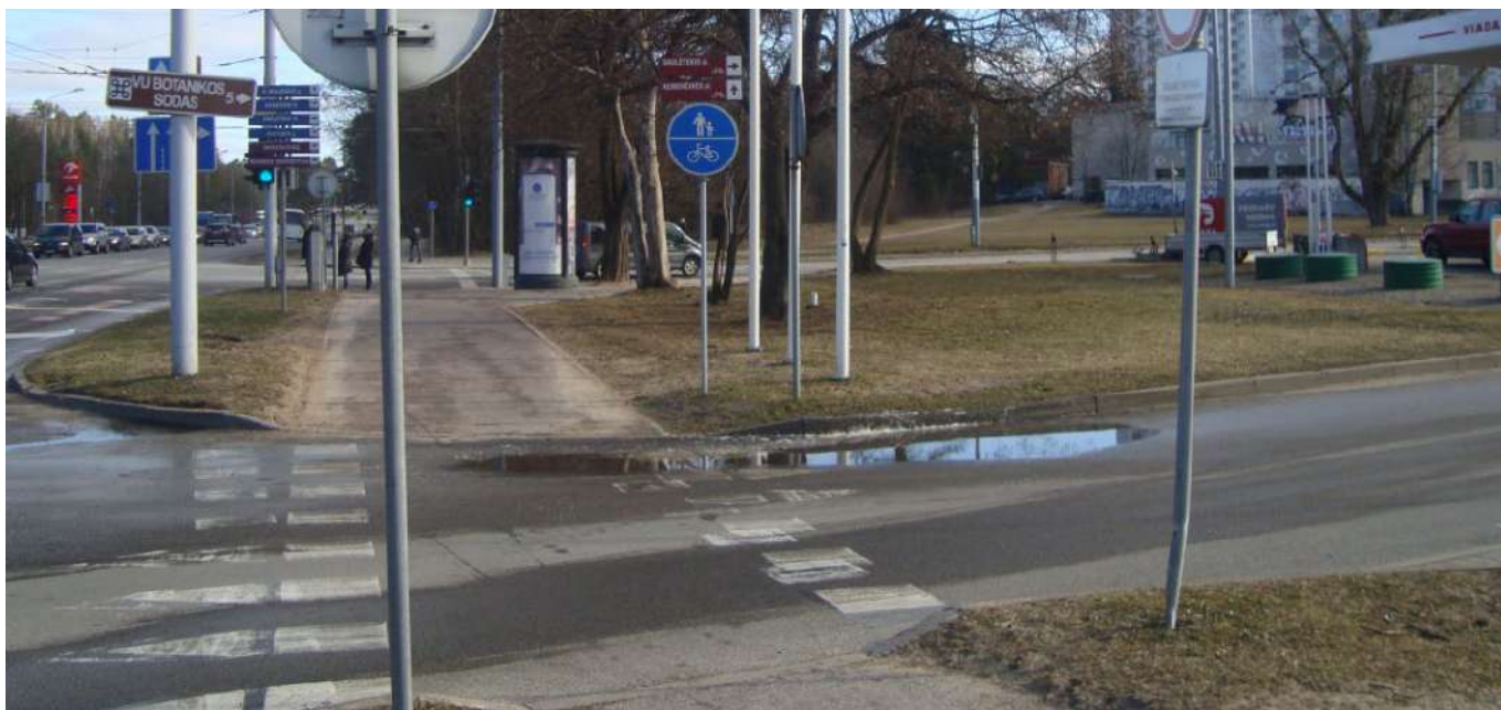
3.7 pav. Nemenčinės pl. –Saulėtekio al. sankryžos esamos būklės fotografacija. Atnaujinta tako dalis.
