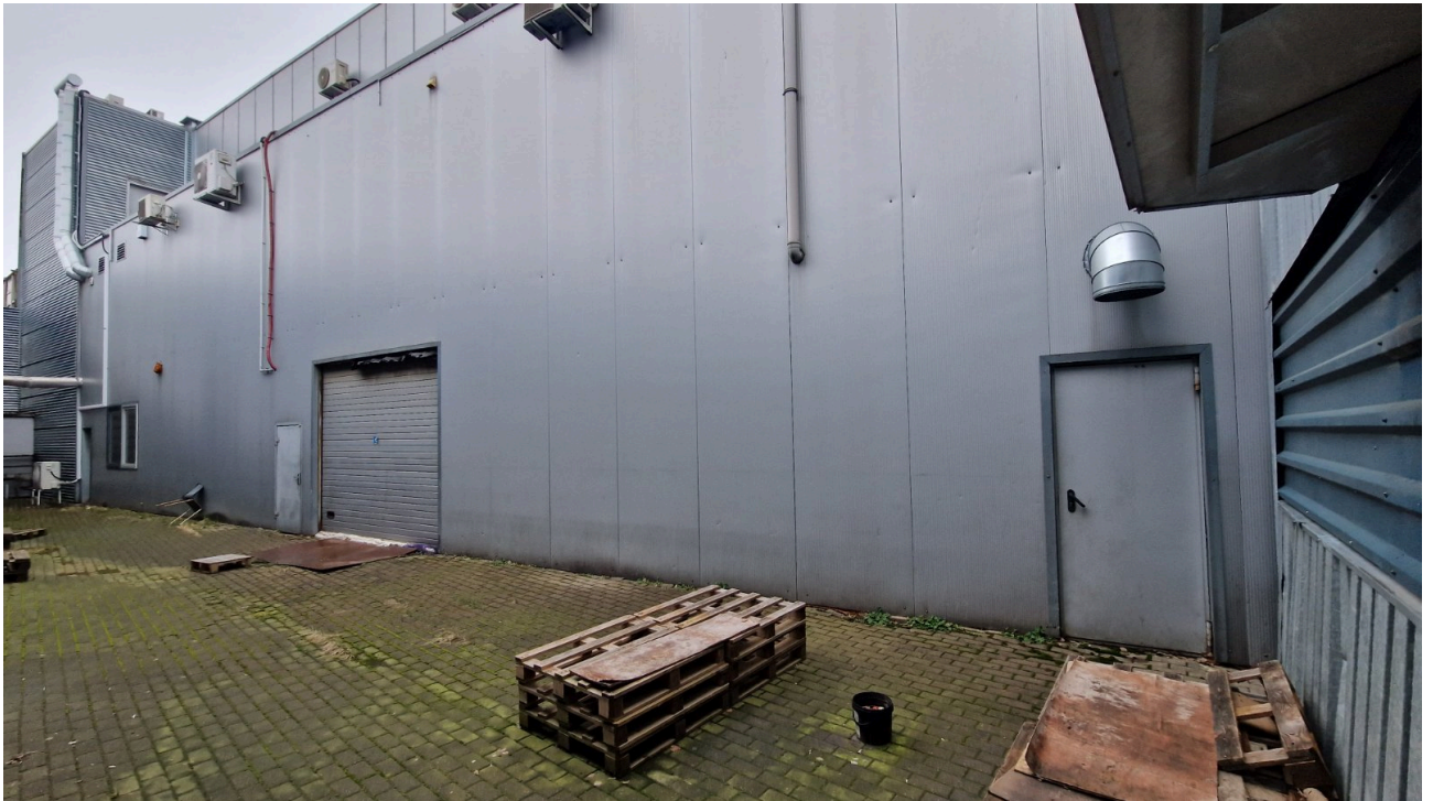
5 pav. Pastato fasadas iš kiemo pusės.
