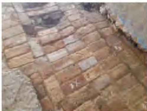
Atidengtos plytų grindys apsidinėje dalyje, atidengtos nuardžius XX a. II pusės betoną.
