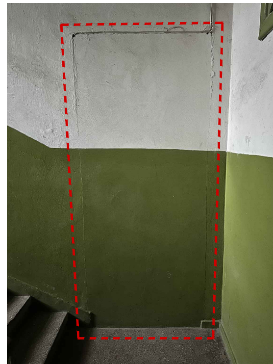
FOTOFIKSACIJA NR.1 Vaizdas į užmūrytą angą bendroje laiptinėje.
