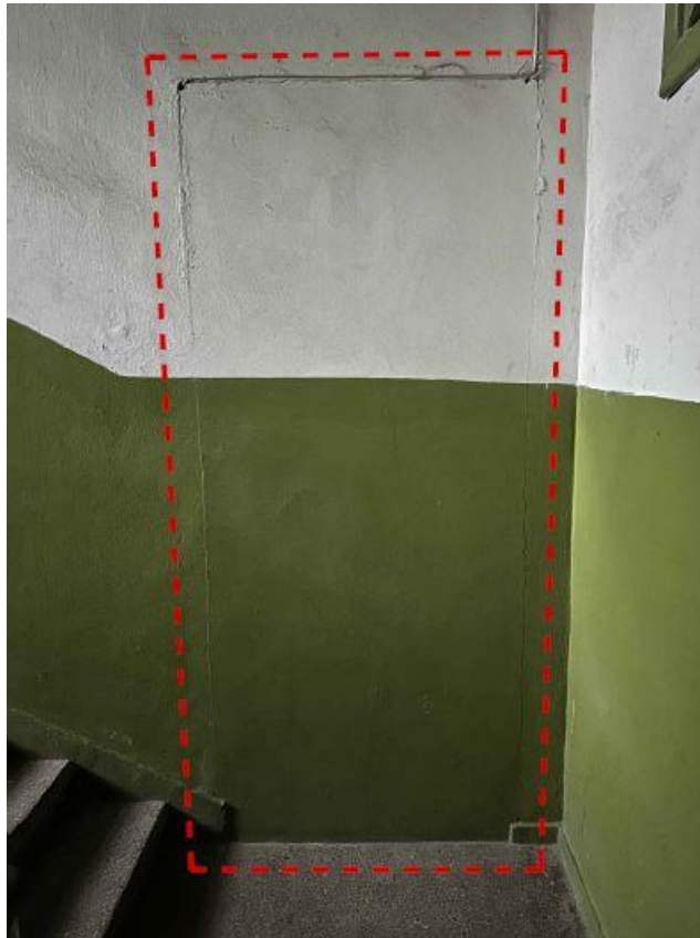
Fotofiksacija nr.1 Bendro naudojimosi laiptinėje matomas įtrūkimai tinke, užmūrytos angos perimetru.
