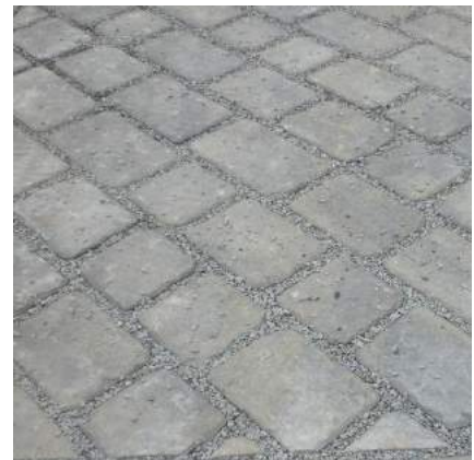
Vandeniui laidži betoninių trinkelėlių danga / 100x200mm
