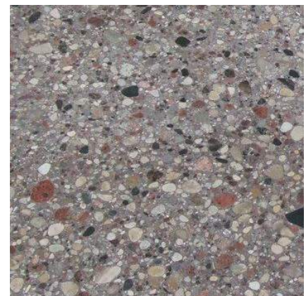
Vietoje šlifotas betonas laiptams ir rampai
