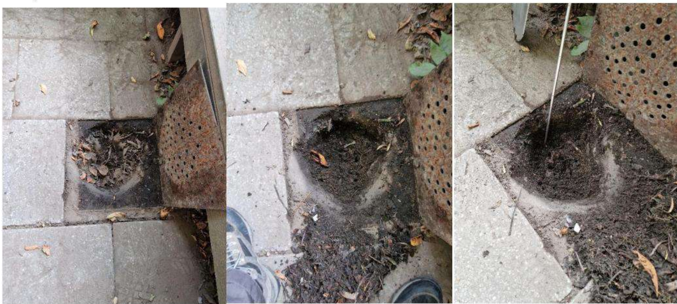
Pav. Nr.2 – lietaus kolektorius terasoje.
