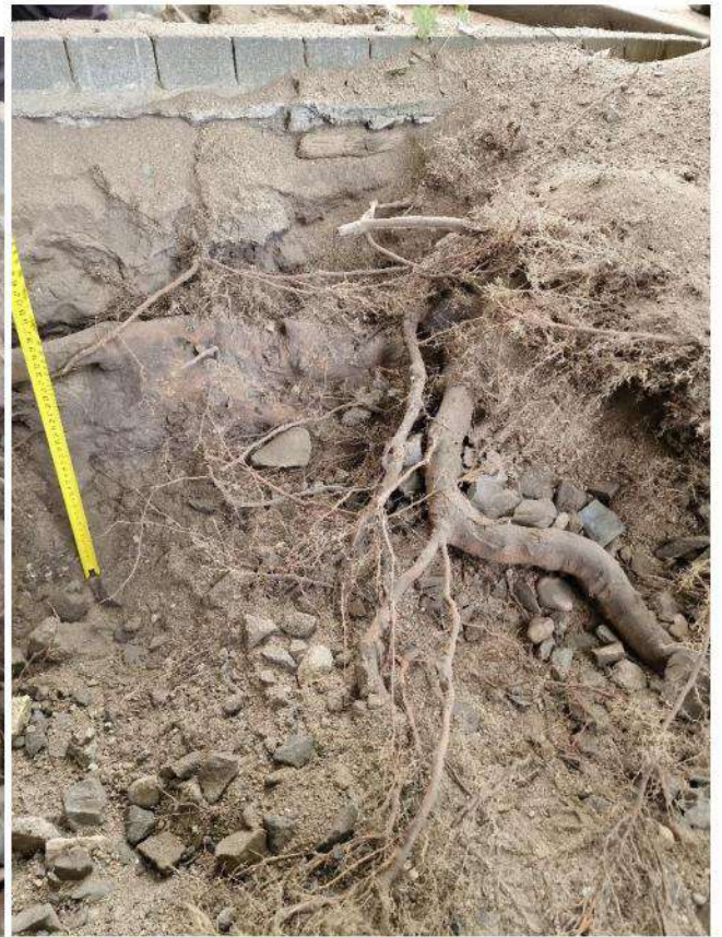
Pav. Nr.9 ir 10. – atraminė klevo šaknis, einanti lygiagrečiai su sienelė. Tai reiškia, kad tiek sienelė, tiek šaknis atsirado panašiu laiku.
