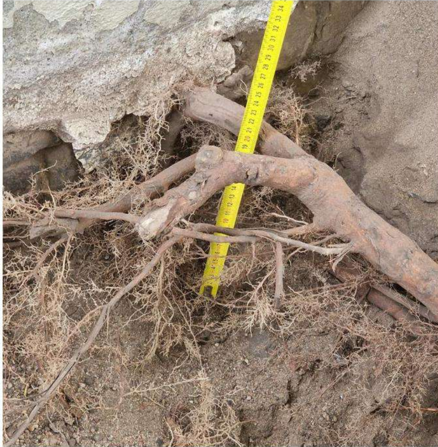
Pav. Nr.11 dalis šaknies (apie 3 cm skersmens) įsiskverbusi į pamatą, kita dalis nuėjusi palei pamatą žemyn.
