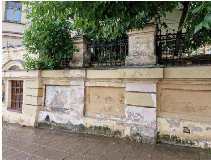
Pav. Nr. 23. Išorinė atraminės sienos dalis. Kairėje apačioje matoma lietaus kanalizacijos iš terasos anga.
