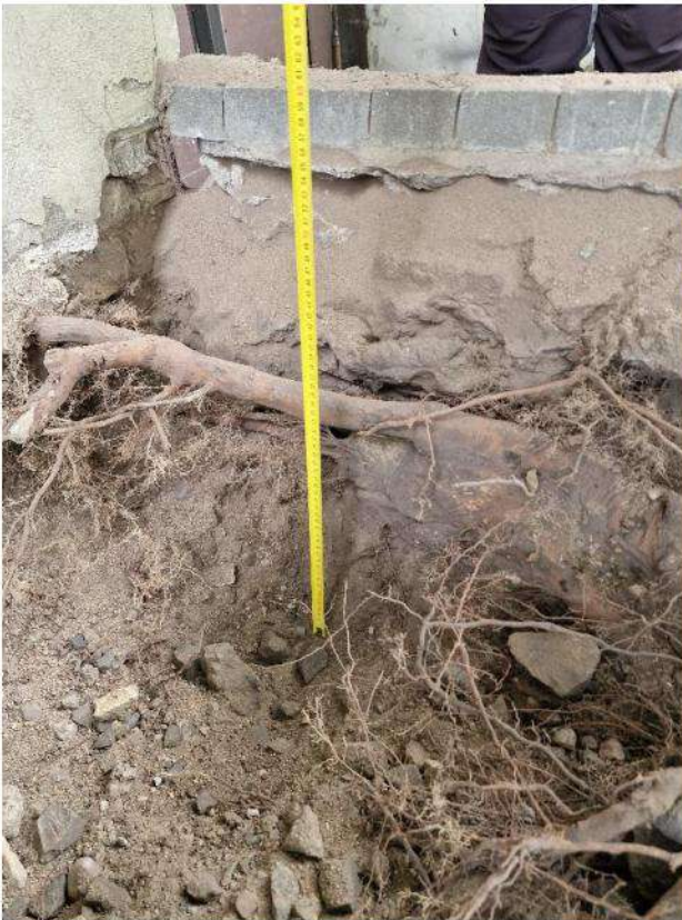
Pav. Nr.9 ir 10. – atraminė klevo šaknis, einanti lygiagrečiai su sienelė. Tai reiškia, kad tiek sienelė, tiek šaknis atsirado panašiu laiku.
