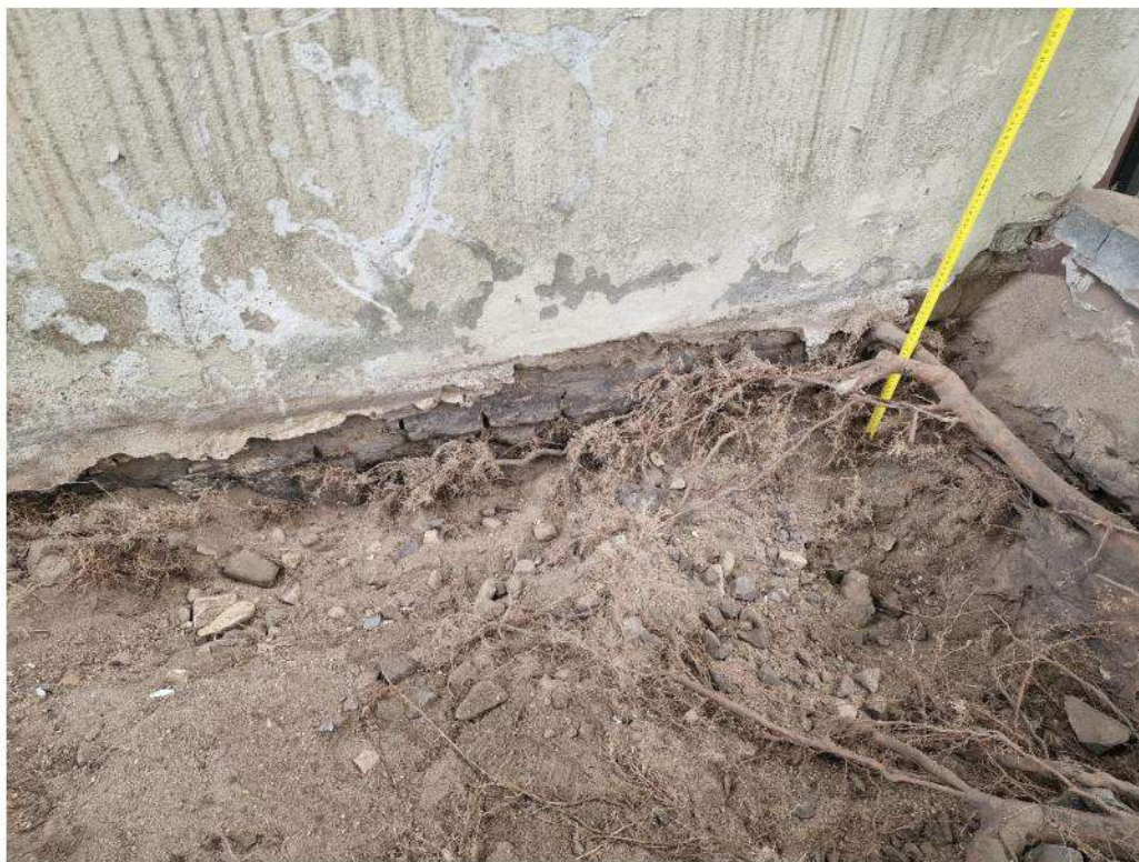
Pav. Nr.16. Klevo šaknynas ir statybinis techninis gruntas prie pastato sienos
