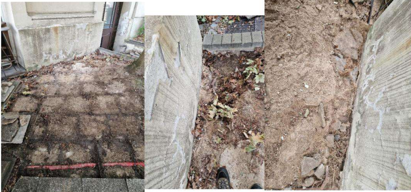
Pav. Nr.12,13,14. Grunto paviršius prie pastato sienos.
