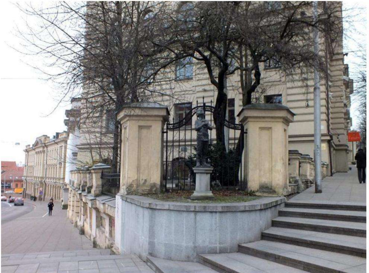
Pav. Nr. 24. 2012 metų lapkričio nuotrauka. Sienelė jau pasvirusi, matomos drėgno mūro žymės.
