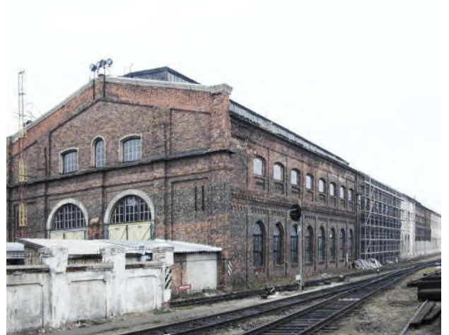
Geležinkelio stoties pastatų fotofiksacija (po ir prieš renovaciją)
