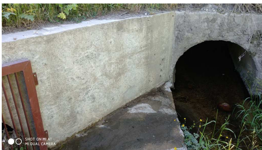
3 pav. Gelžbetoninė pralaida d1200.
