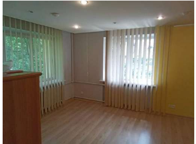
pav. 4. esama patalpų būklė. Stomatolog. kab. pat.nr. 19-3
