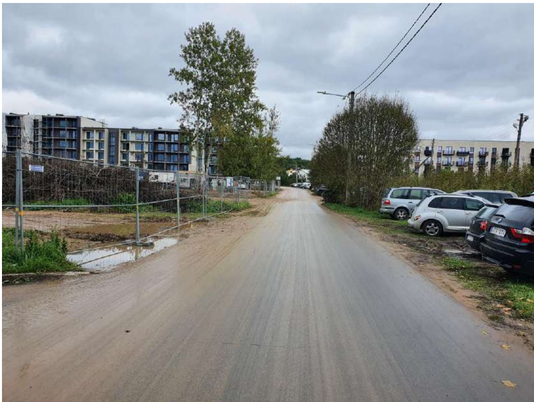
3 pav. Lietaus g. (gatvės viduryje vykstančios daugiaaukščių gyvenamųjų pastatų statybos)
