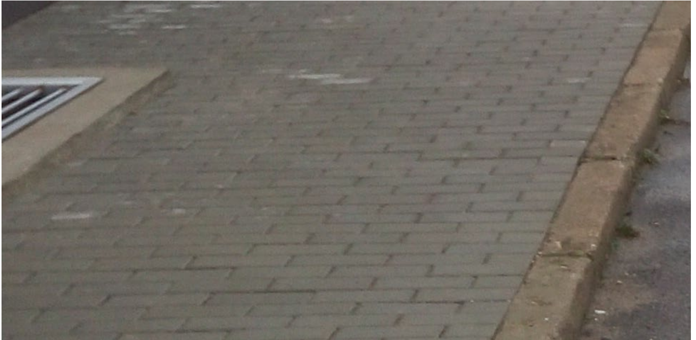
Pav. nr. 2: fotofiksacija nr. F1, 2018-11-19. Geros būklės šaligatvis
