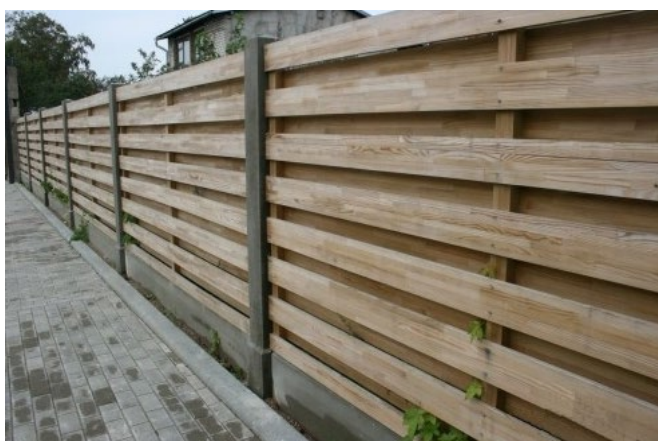
Āpsauginė sienelė prie automobilių stovėjimo aikštelės
