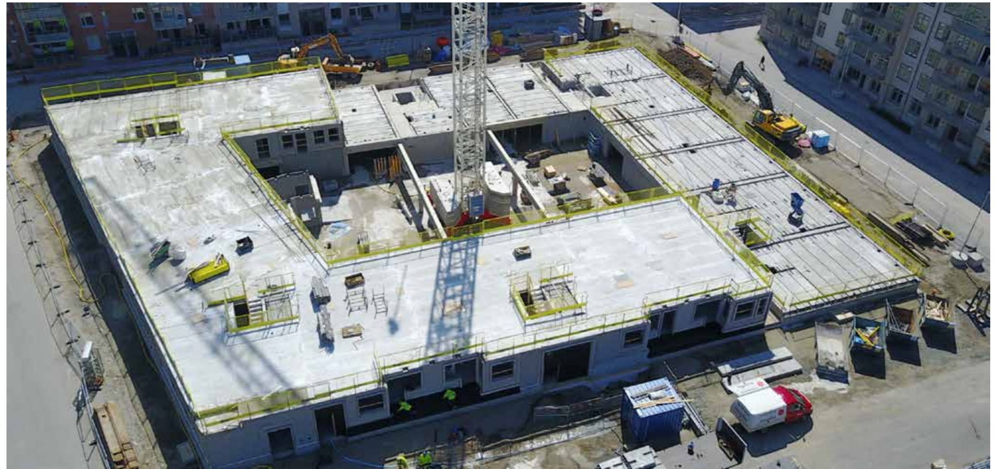
Surenkamo gelžbetonio konstruktyvas
