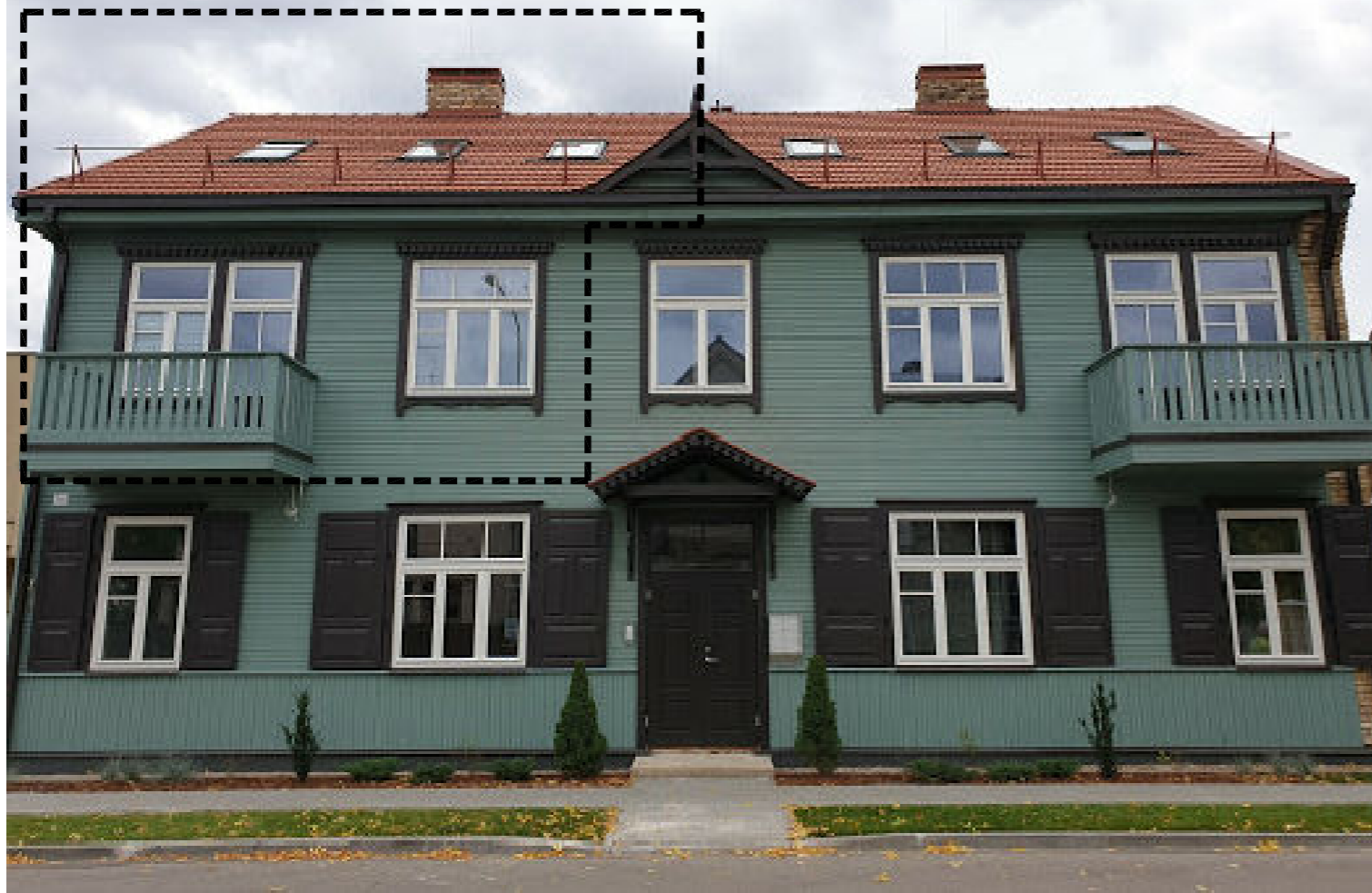
REMONTUOJAMAS BUTAS Nr. 3
